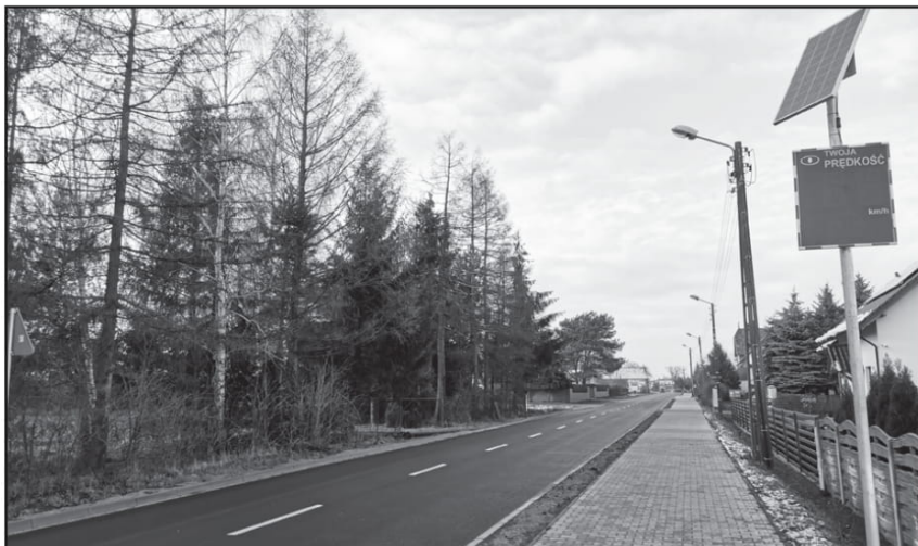
Wyremontowana droga Gołanice – Jezierzycy Kościelne, przyjazna dla zawieszania naszych samochodów
